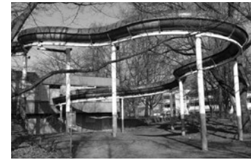
Das ehemalige Stadtbad in Marl
